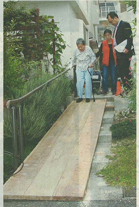
より良いリフォームに向けて、事例を研究するメンバーら。愛知県春日井市で
